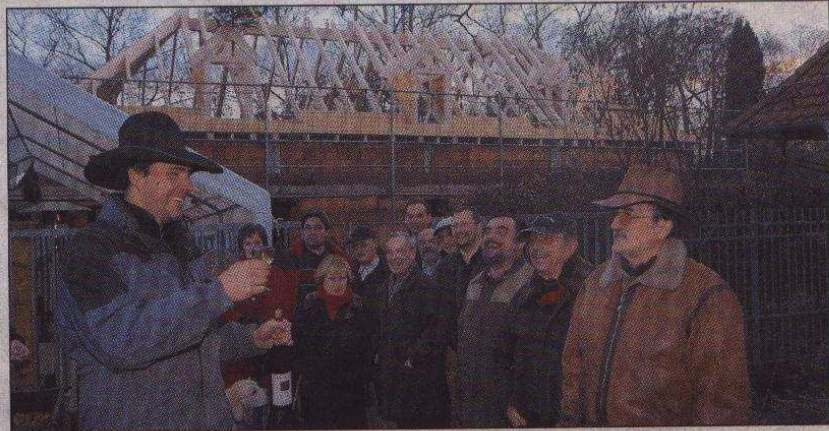
Richtspruch für dem zweiten Bauabschnitt an der Fasanerie: Zimmermann Max Bär (links) bringt ihn aus. Foto: wita/Stotz
